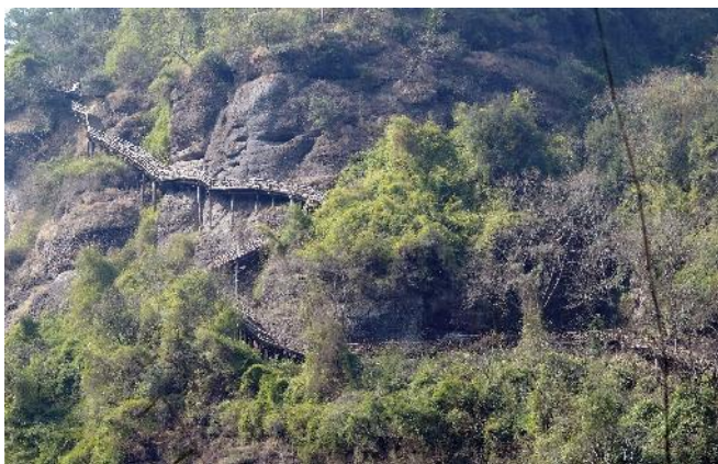
下ってきた「天梯峡栈道」を見上げる
