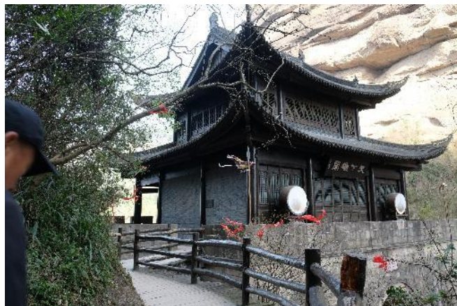
「劍門関楼」の上部建築物
