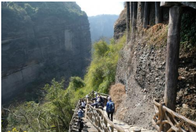
「天梯峡栈道」を下る。右上には栈道を支える柱が有る
