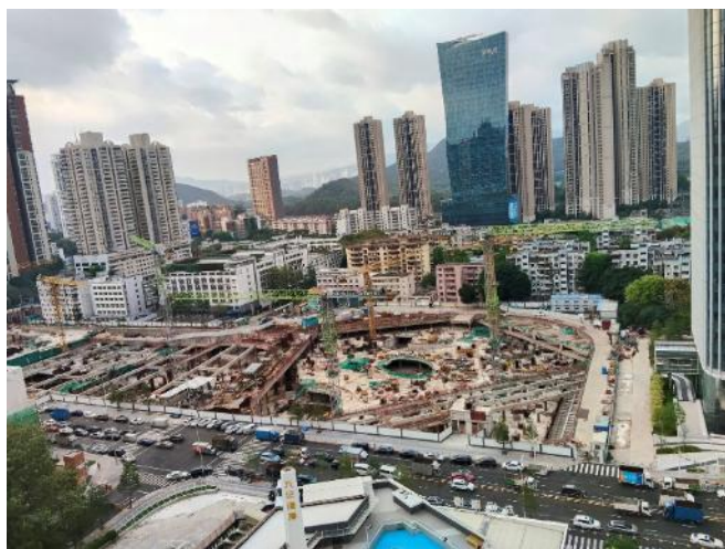
地下鉄工事現場(2026年4月撮影)
