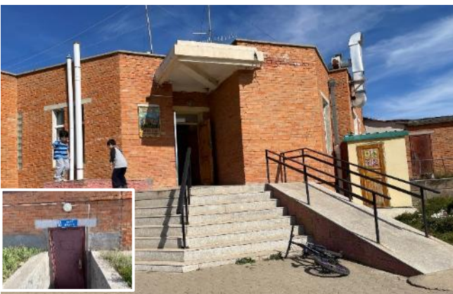
正面玄関とスロープ、左下写真は半地下のトイレ入り口
