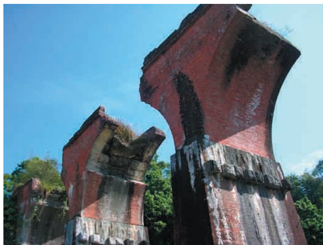
「龍騰断橋」、崩れ落ちた橋梁
