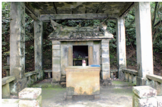
山神様のほくら、コンクリート製である
