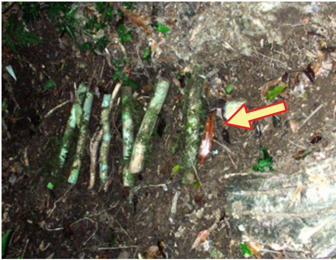
行き届いた「水切り」の例。←の方向に流れる雨水の勢いを弱めるため小枝を並べてあった。
