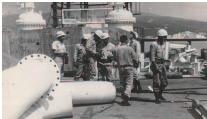
後方の円筒形が流量測定機器。手前の資材が継ぎ手など。
