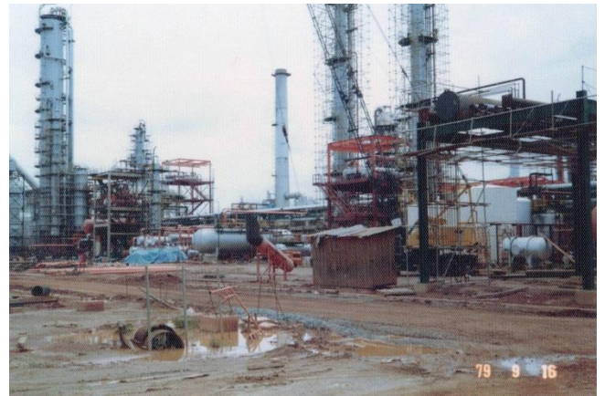
ぬかるみの中の現場
