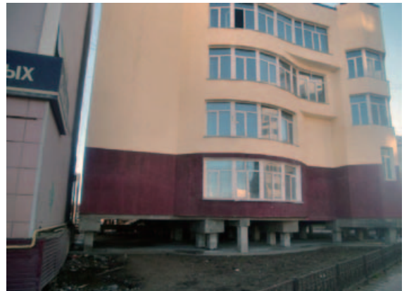
高床式アパート ヤクーツクの建物は大半が高床式です。永久凍土地帯なので、長い杭を打ち込んで、建物から出る熱で表層の氷が溶けないように「床を浮かせて」建てるのです。
