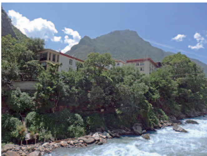
前は川、後は急斜面の山に挟まれた校舎
