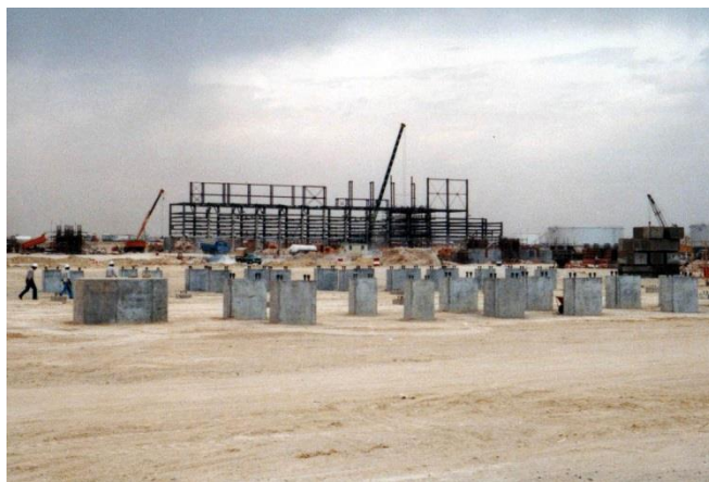
砂漠の中の製油所建設現場
