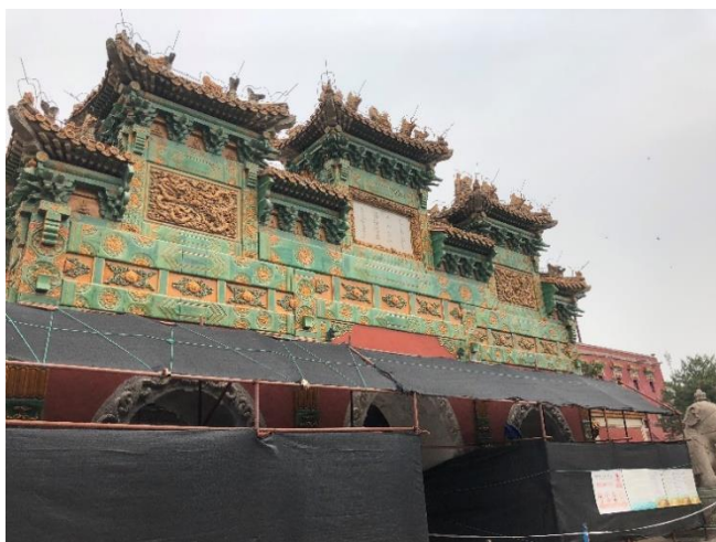
修復工事中だった琉璃牌坊
