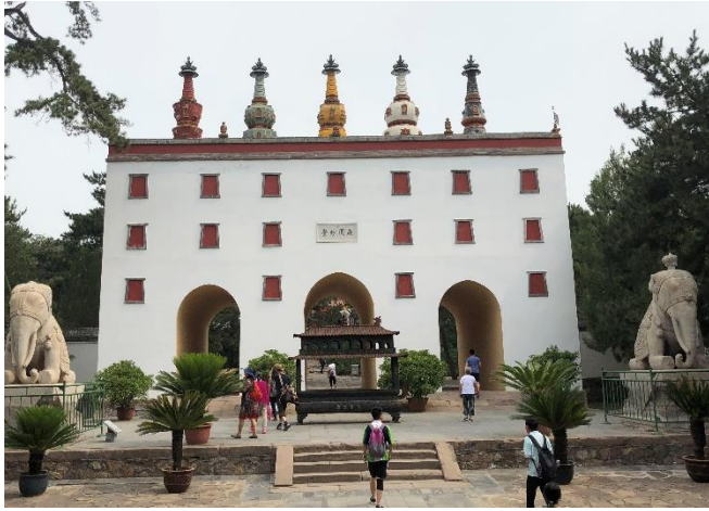
屋上に5種類の塔が並ぶ「五塔門」
