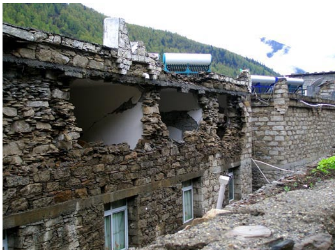
2階部分の損傷が多い。
