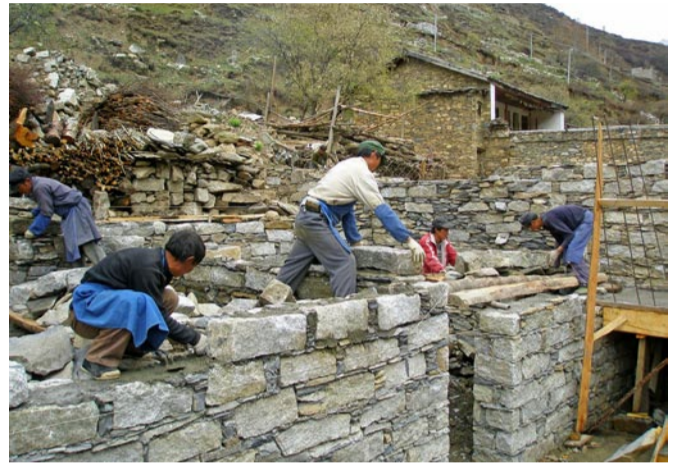
写真2 以前の壁は泥で固めていましたが、昨年の地震で壊れた教訓から今ではセメントで固めながら積む家がほとんどです
