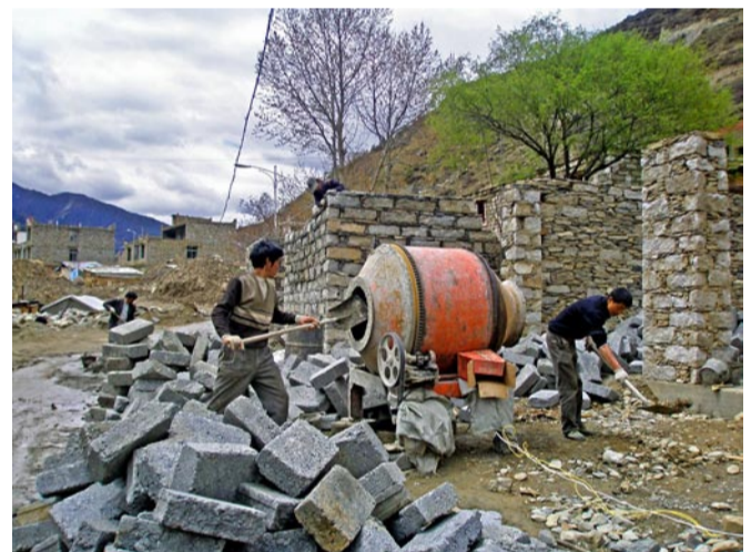
写真3 コンクリートブロックは日本で多く使われているものと違って空洞がありません。
