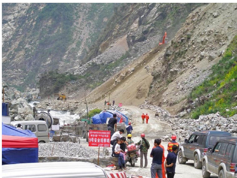
写真2 川岸に沿った道では彼方此方で崩れた斜面を護る工事が進められ、短時間だが数ヶ所で待たされた
