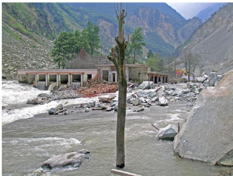
写真3 崩れ落ちた岩が川を埋めて水位が上がったため、住宅の廃墟の中を川の濁流が洗っている所もあった
