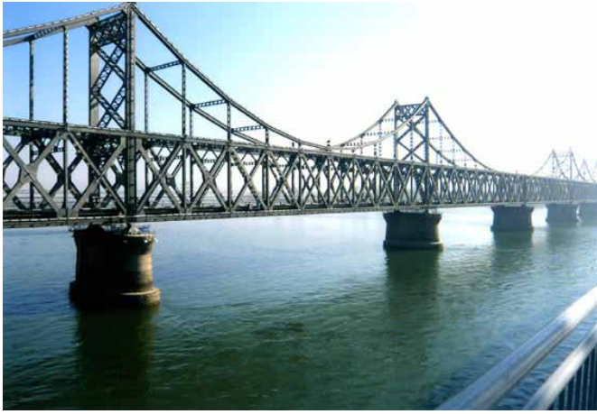
断橋の上から撮影の「中朝友誼橋」手前に断橋の手すりが見える
