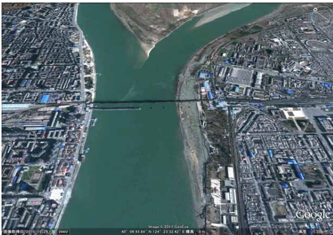
鴨緑江に架かる、中朝友誼橋と断橋。上の黒い筋が「中朝友誼橋」で、そのすぐ下の「断橋」は北朝鮮側の半分が壊れているのがよく分かる
